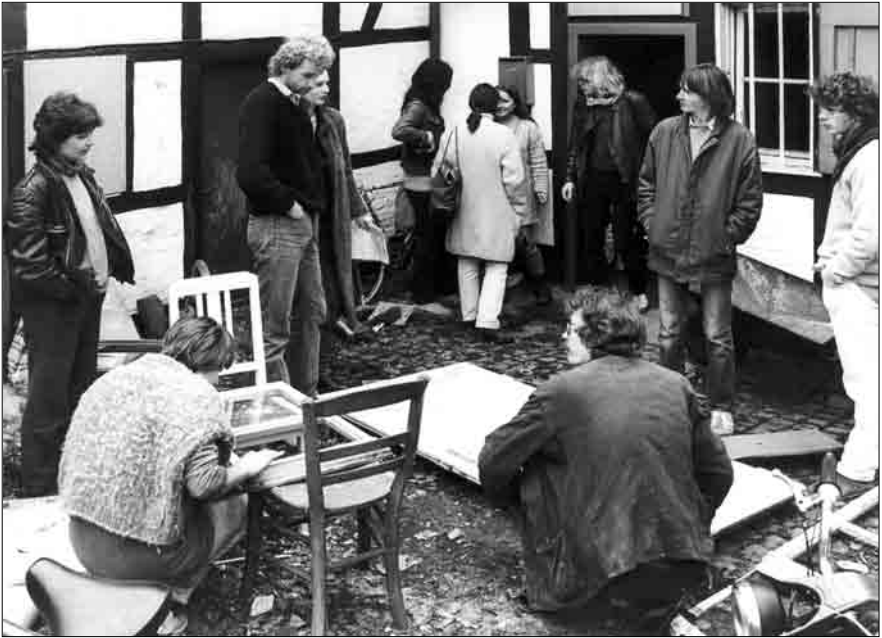
Abbildung 1: Renovierungsarbeiten Hilden, Marktstr. 11, 4.4.1981, Stadtarchiv Hilden
